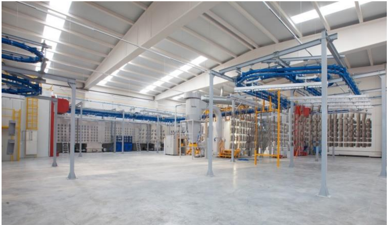
Vista general de la instalación
