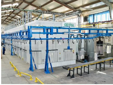
Foto 1 Horno de polimerizado de pintura y salida del túnel de tratamiento.
